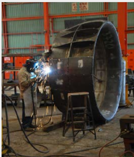
Figura 1. Soldadura de estructura que conforma la tobera
