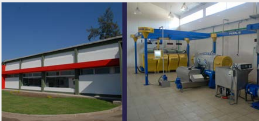
Figura 2. (a) Edificio de la Planta Piloto (b) Maquinaria para la extracción de aceite de oliva
